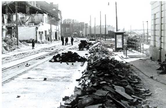
Слика 17 – зграда Хотела Крагујевац – рушење
