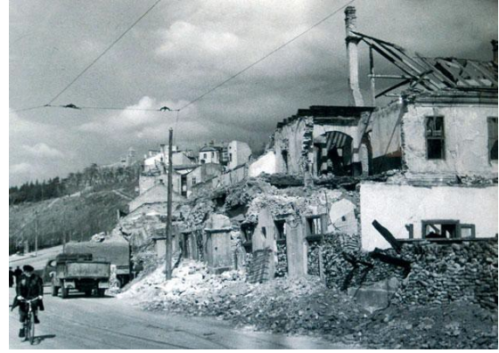
Слика 19 – Зграда Ђумрукана – рушење
